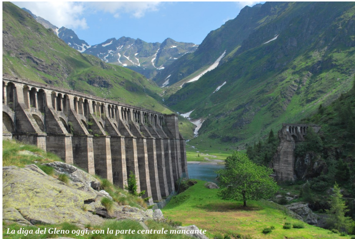
La diga del Gleno oggi, con la parte centrale mancante
